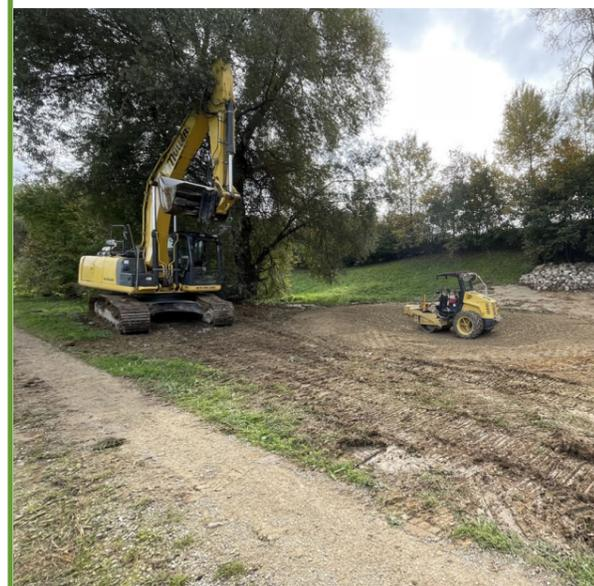
Mitte Oktober werden die Sanierungsarbeiten ausgeführt. Ein Teil des Weihers und die Tümpel werden ausgebaggert und nachher mit kalkstabilisiertem Bodenmaterial abgedeckt. Wichtig ist, dass das Material verdichtet wird (oben 7.10.2022, rechts 16.10.2022).
